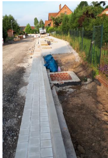
Baustelle Hauptstraße Pohle
